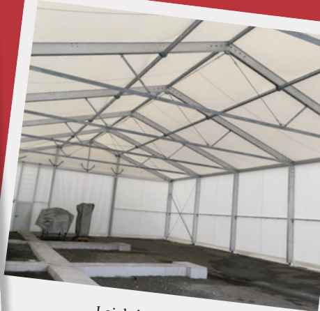
Leichtbauhalle für Anlagenbau Werkstätte
