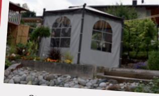
Stams: PVC-Planen mit eingearbeiteten Fenstern für Gartenpavillon
