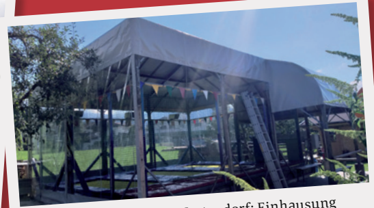
Trampolinanlage Westendorf: Einhausung der Trampolinanlage mit PVC und Klarglas-PVC zum Schutz vor Witterung
